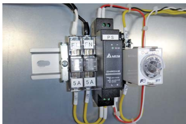
PAL-Onlyユニット設置・電線接続
